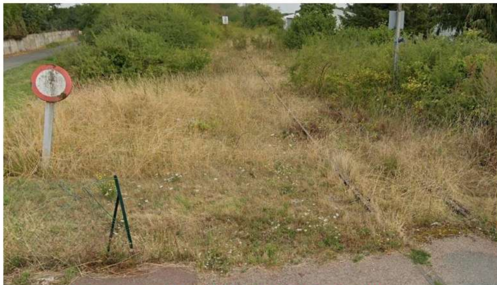
Figure 6. Vue vers le nord sur le PN6 (Rue Albert Frappin)
