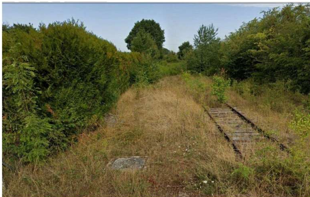
Figure 7. Vue vers le nord sur le PN 10 (Rue de Pisseux)
